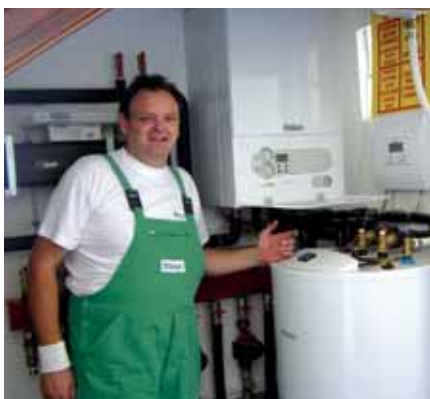
Uz kondenzacijski uređaj ecoTEC, ugrađen je i spremnik VIH od 200 l te solarna regulacija VRC 630
