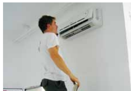
Djelatnici tvrtke Aki-d-vod besplatno su montirali klima uređaj
