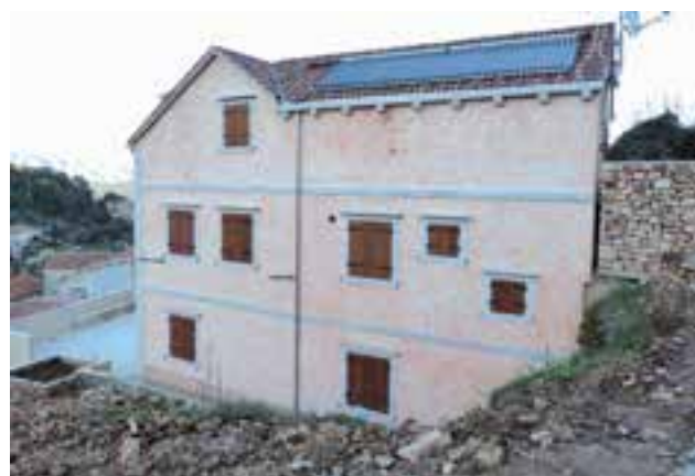
Vakuumski kolektori vile Vrbanj
