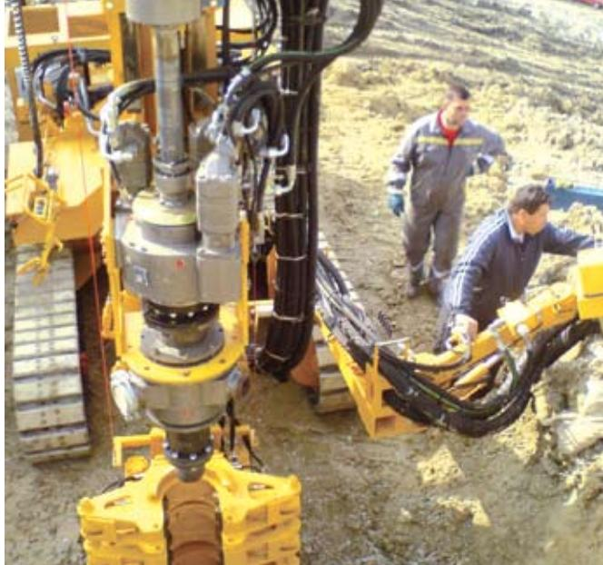
Priprema stroja za izvedbu geotermalnih sondi
