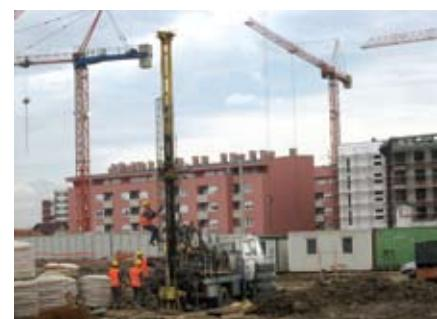
Ugradnja piezometra za mjerjenje razine podzemnih voda u naselju
