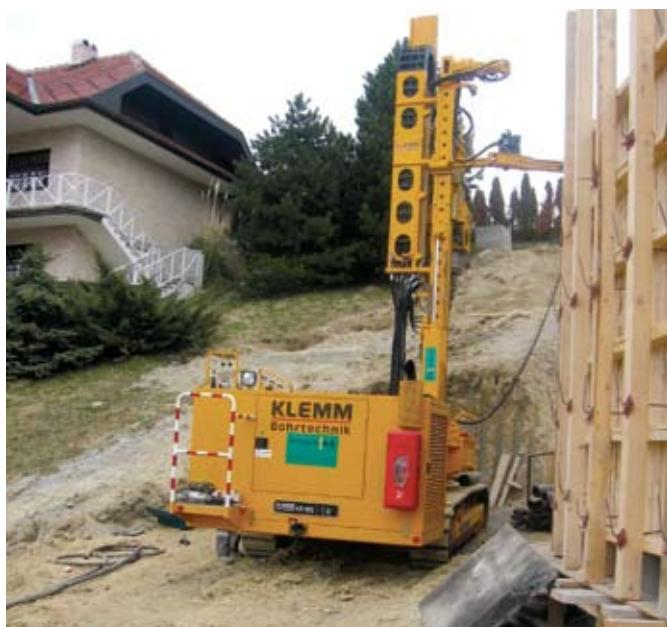
Namjenski stroj za izvođenje geosondi marke Klemm KR 805 - 1W
