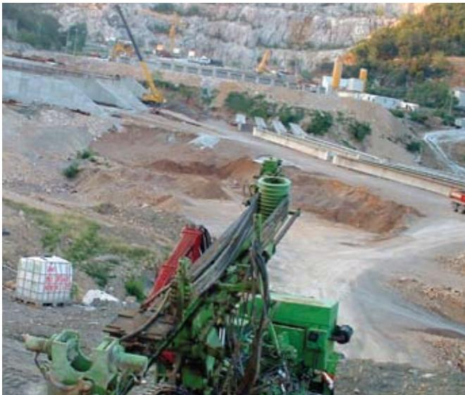
Ugradnja geotehničkih sidara na obilaznici Rijeka
