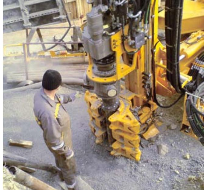
Faza izvedbe bušotine za ugradnju geotermalne sonde
