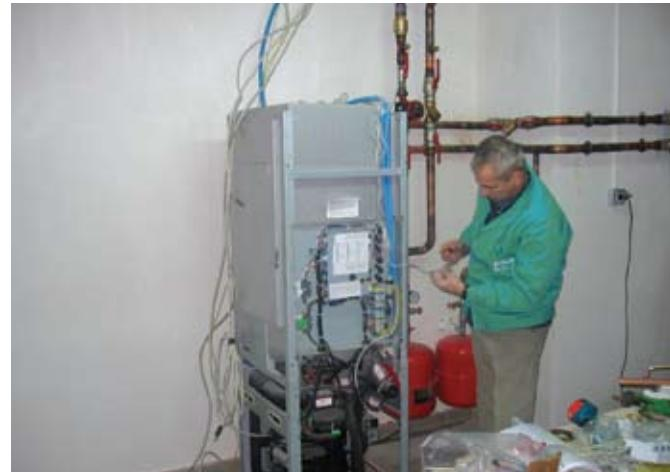
Puštanje toplinske crpke u pogon od strane ovlaštenog Vaillantovog servisera
