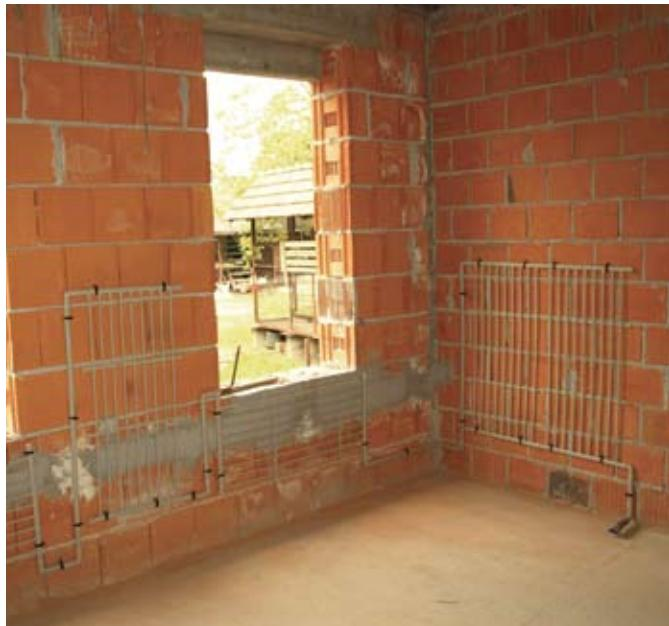
Niskotemperaturni zidni sustav grijanja
