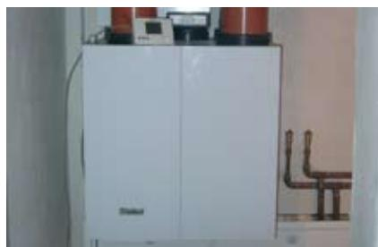
Osim toplinskog crpkom, objekt je opremljen i Vaillantovim ventilacijskim sustavom recoVAIR
