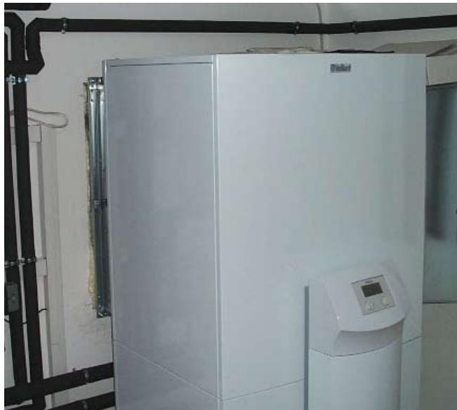
Toplinska crpka zrak-voda za grijanje i pripremu PTV geoTHERM VWL 91/1
