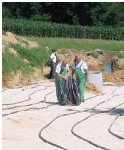
Izvedba površinskog geotermalnog kolektora
