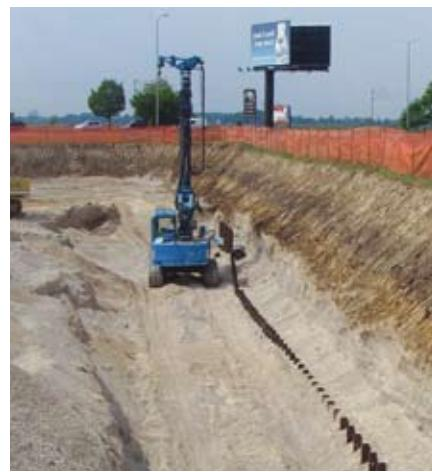
Ugradnja geotehničkih pilota u Buzinu, Zagreb
