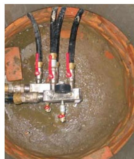
Revizijsko okno površinskog geotermalnog kolektora
