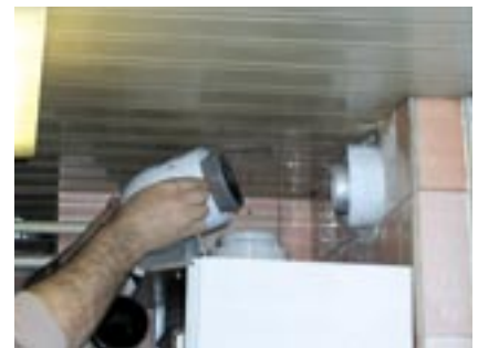
Spajanje zrako-dimovodnog sustava
