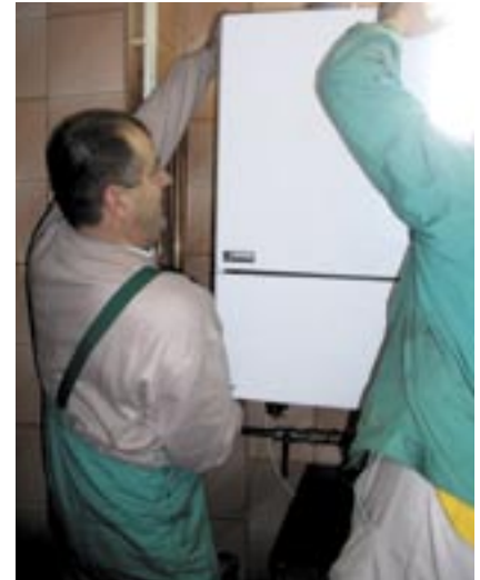
Skidanje starog uređaja sa zida
