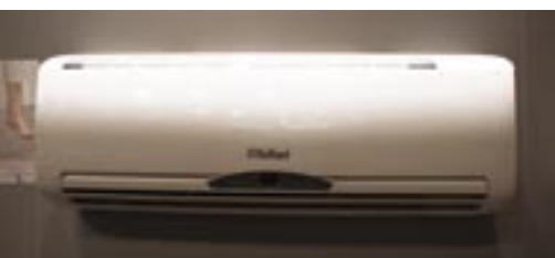
Unutarnja jedinica super-inverter klimate, opremljena je posebnim infracrvenim senzorom koji reagira na ljudske pokrete, svjetlost i temperaturu
