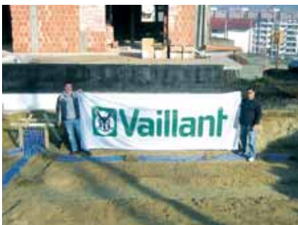
Osim kolektora, postavljene su i dvije dubinske sonde
