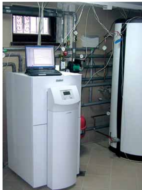
U kotlovnici su, osim toplinske crpke postavljeni i spremnik VIH te vrnetDIALOG
