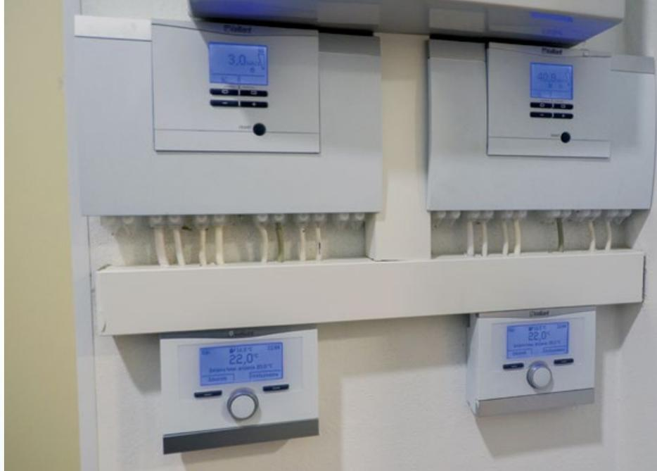
multiMATIC 700/6 upravljačke jedinice sustava
