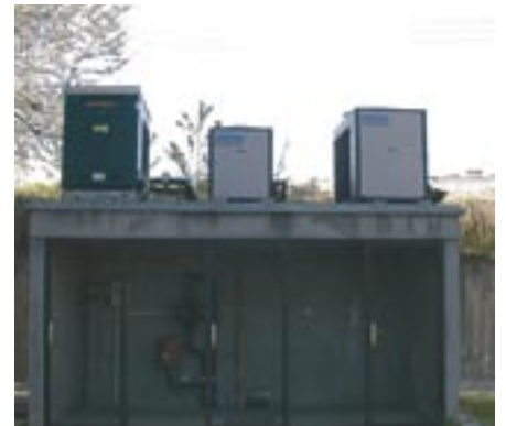
Apsorpcijski rashladni uređaji na plin za potrebe GPZ-a
