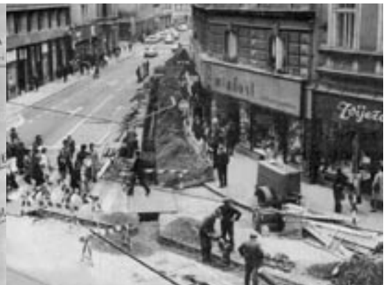
Rekonstrukcija plinovoda na križanju Petrinjske i Jurišićeve 60-tih godina
