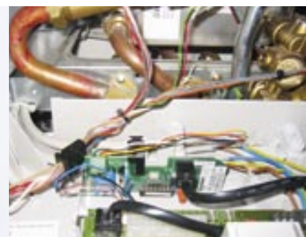
Modul VR30 ugrađen u zidni uređaj
